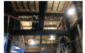
#梁に溜ったすす汚れを掃除中
